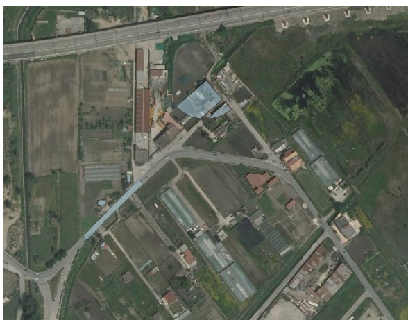
Foto 1 - Le aree a rischio R3-R4 su via Lufrano (rif. 1 in fig. 3)
